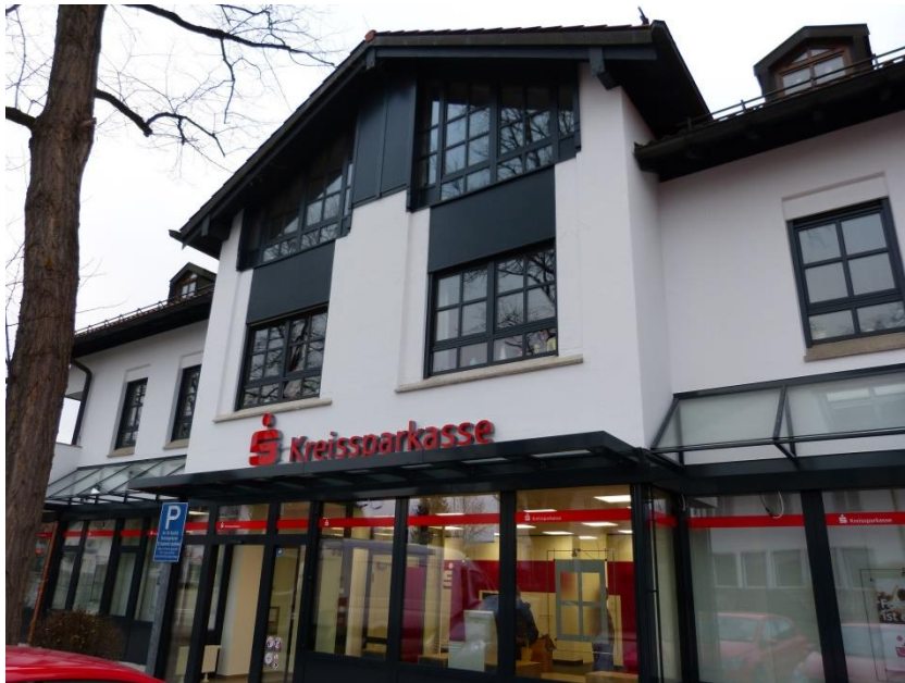
Außenansicht der rundum erneuerten Kreissparkasse in Siegersbrunn
